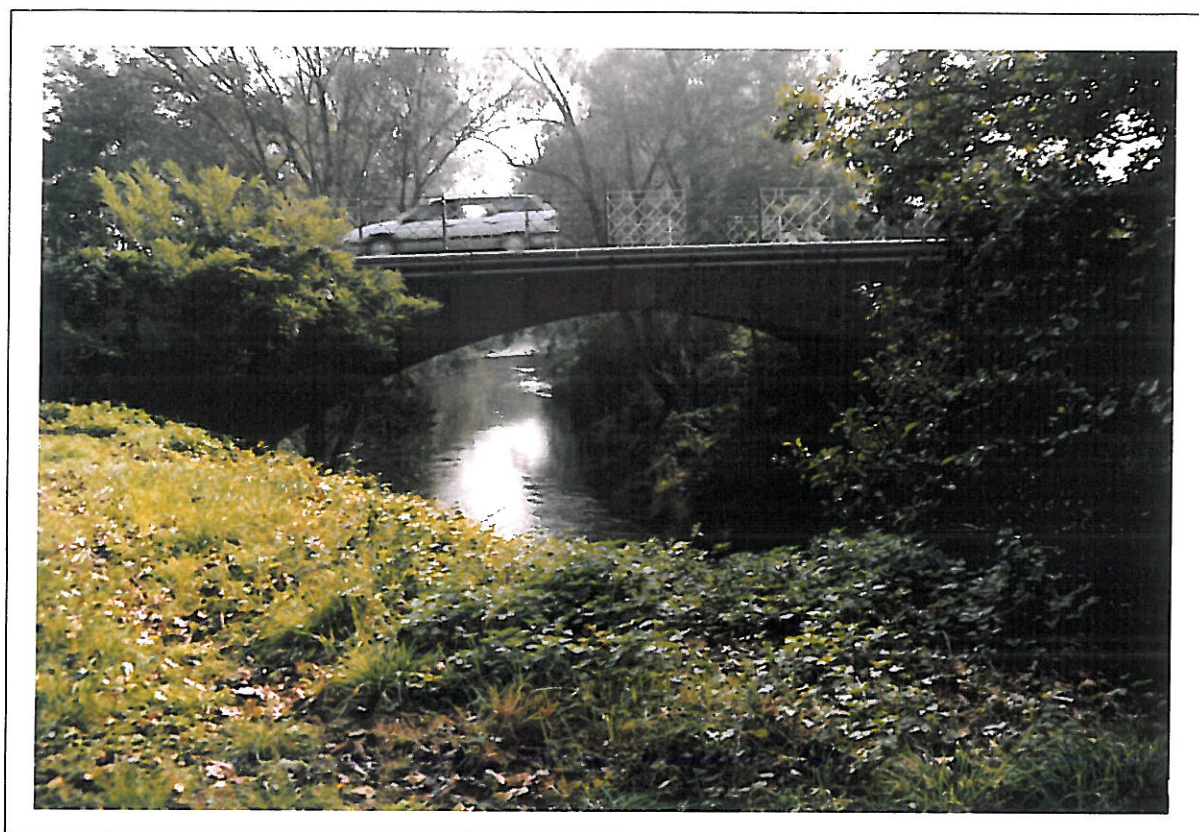
Foto 29 – Primo piano del ponte sulla S.P. N° 2 che conduce a Veveri: il piano stradale si trova ad una quota superiore rispetto ai campi adiacenti. La luce del ponte molto ampia favorisce il deflusso delle acque in caso di piena eccezionale, impedendo il formarsi di ostruzioni dovute ad eventuali tronchi d'albero divelti e trasportati dal torrente stesso.
