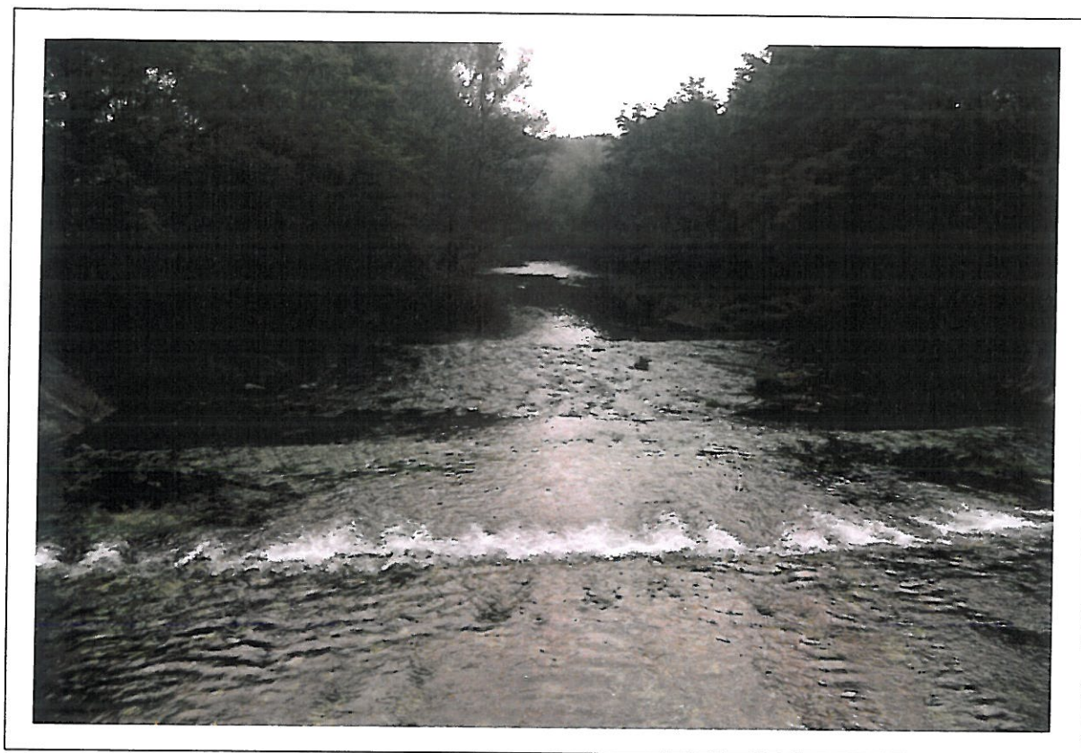
Foto 15 – Tratto a valle della passerella in cls per l'attraversamento del T. Terdoppio. Sono riconoscibili le tre soglie posizionate in successione a breve distanza l'una dall'altra. A valle delle terza soglia, in destra idrografica, si distingue una barra laterale parzialmente coperta da vegetazione arbustiva.
