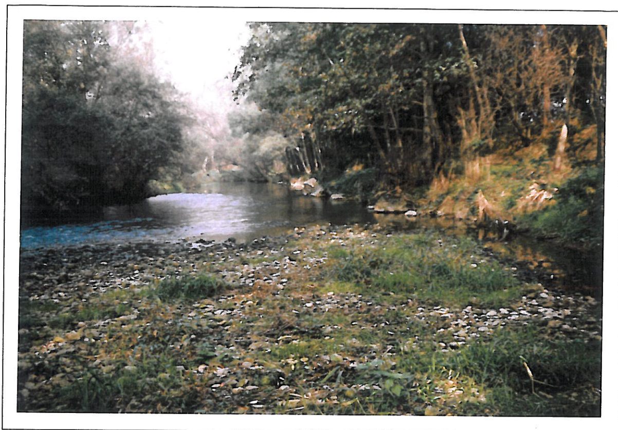
Foto 17 – Meandro del T. Terdoppio all'altezza di C.na Bollini. E' ben visibile in sinistra idrografica la scogliera in blocchi irregolari sparsi. In primo piano c'è la testa della barra longitudinale: l'assenza di vegetazione conferma la possibilità di facile esondazione della stessa in caso di eventi di piena.
