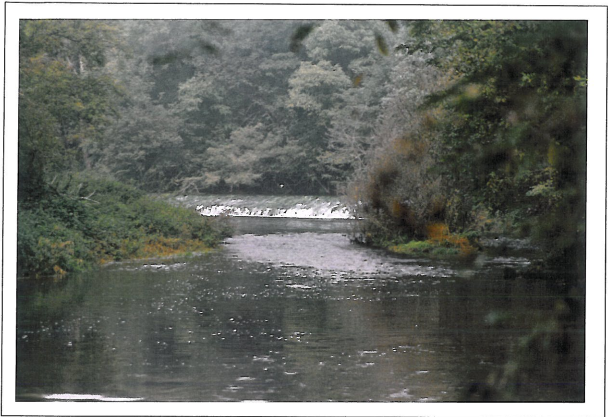
Foto 9 – Primo piano della soglia. Sono inoltre ben visibili le due barre fluviali presenti a valle della soglia: entrambe sono colonizzate da vegetazione arbustiva e alberi a basso fusto e sono esondabili in caso di eventi di piena.
