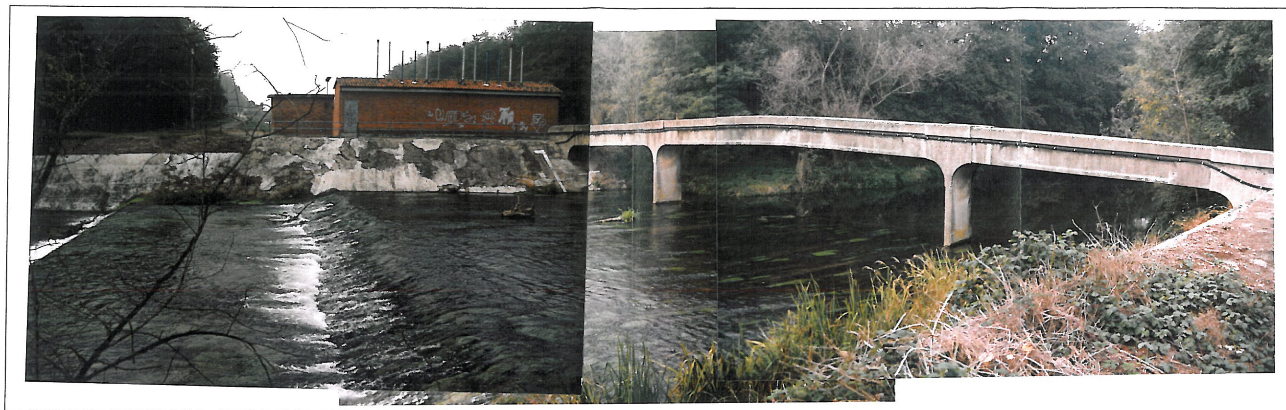
Foto 16 – Panoramica della zona di attraversamento del T. Terdoppio mediante passerella in cls. Sono visibili le due soglie e uno dei due muri d'ala in cemento a valle della passerella. In corrispondenza dell'edificio in mattoni rossi passa trasversalmente al corso d'acqua il Canale Cavour, sifonato in questo tratto.
